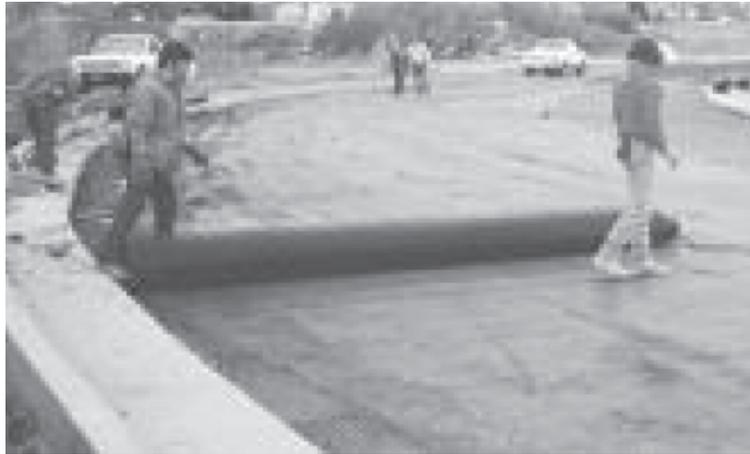
**Figura 33. Corrección de arrugas y corte de la geomalla**
