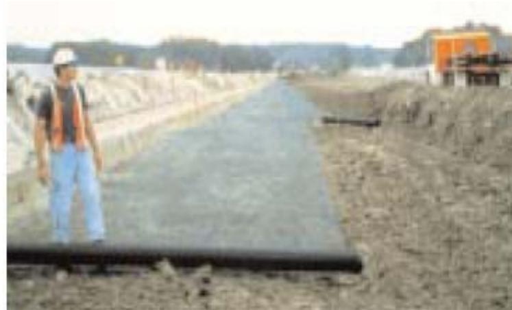
Esto se logra mediante la distribución de cargas de manera más eficiente, reduciendo la presión sobre la sub-rasante, mejorando de este modo su desempeño, utilizando el mismo principio de las raquetas para nieve, que soportan el peso de un hombre sobre la nieve blanda, transformando la carga puntual en una carga distribuida.
