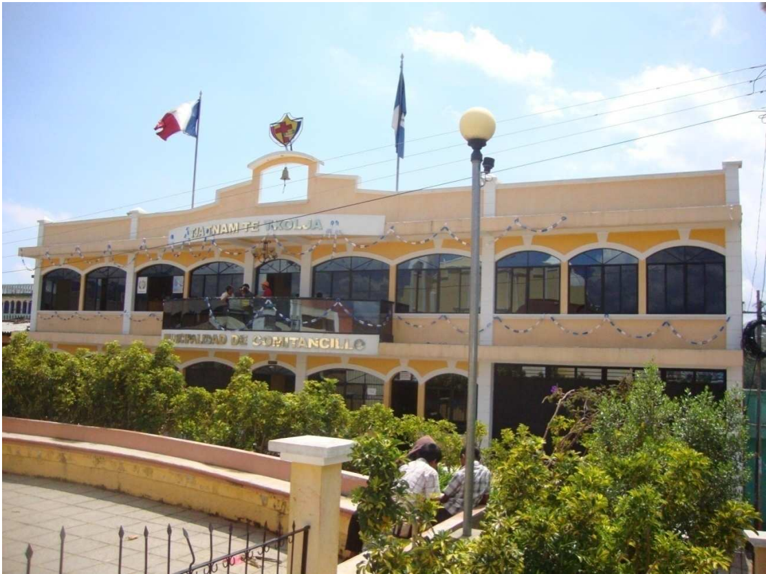
Fuente: fachada principal, Municipalidad de Comitancillo, San Marcos.
