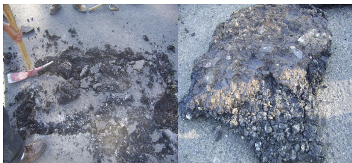
Figura 12. Muestreo de carpeta de rodadura
