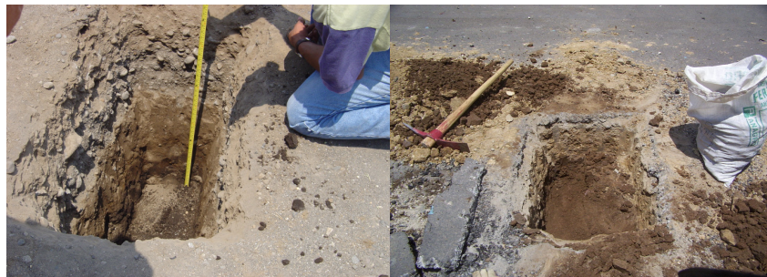
Figura 15. Ejemplo de un pozo a cielo abierto terminado
