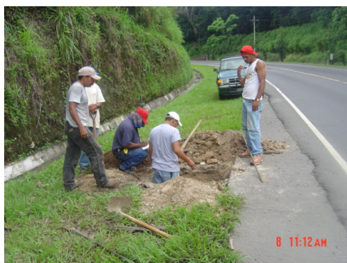
Figura 20. Fotografías de excavación de pozos a cielo abierto para muestrear los materiales del pavimento
