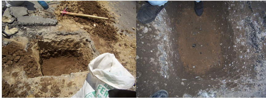
Figura 14. Muestreo de la sub rasante
