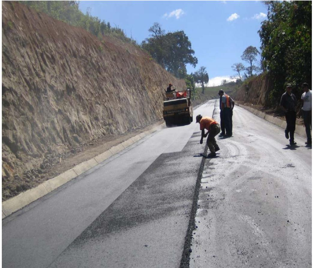
En el proceso de compactación fue utilizado únicamente un rodo vibratorio doble tambor. No es necesario utilizar una compactadota neumática.
