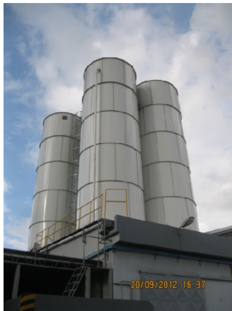
Figura 4. Silos de almacenamiento de harina
