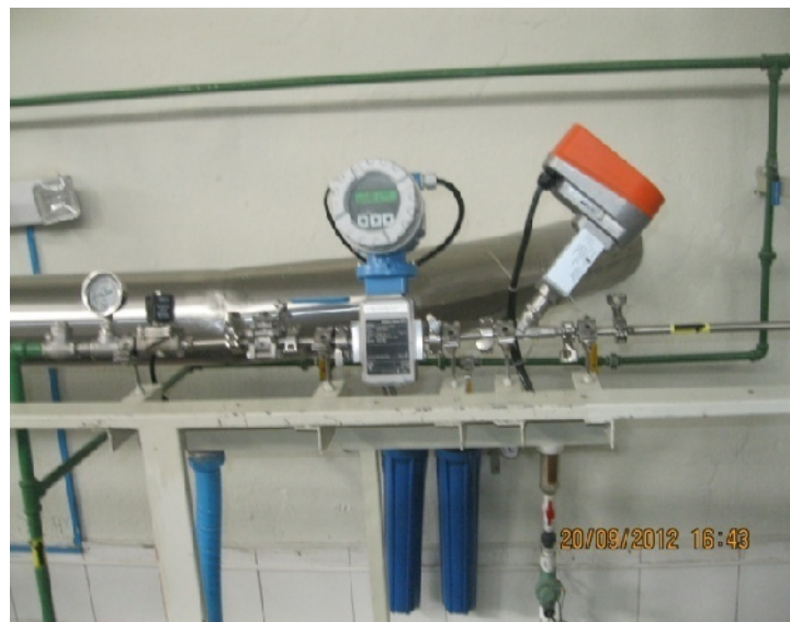
Figura 7. PLC para control de flujo de agua
