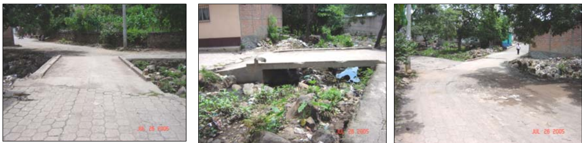
Figura 29. Panorámica de puente existente.
