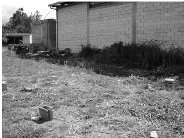
Figura 9 Lugar donde se localizará el edificio del departamento de mantenimiento, en el área de prefabricados
