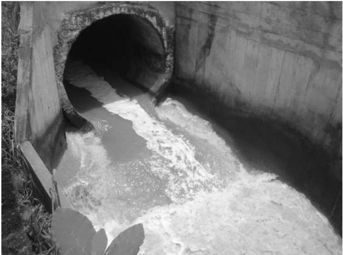
**Figura 9. Resalto hidráulico en descarga Las Buganvillas**
