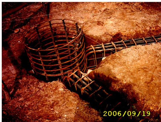
**Figura 12. Armadura de la zapata unida con la pletina**
