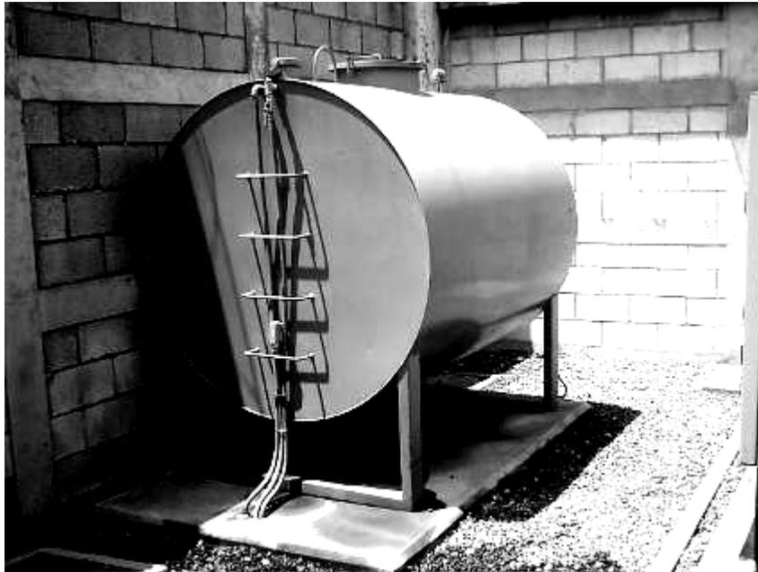
El tanque mensual es un contenedor metálico en el cual se guarda combustible diesel, el cual tiene una duración de un mes calendario y su función principal es la de abastecer de combustible al motor generador y con esta alimentación eliminar cortes de energía dentro del sitio.
