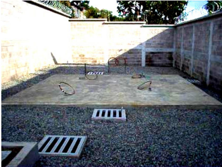
La base donde se colocará el equipo G.S.M. se hará de concreto reforzado y tendrá como función evitar que el equipo que brinda la señal G.S.M. tenga contacto con el agua, para lo cual se construirá a 0.15 metros sobre el nivel del suelo, esto se hace debido a que la señal para celulares que recibe o envía el aparato G.S.M. se hace defectuosa cuando se filtra agua dentro del equipo.
