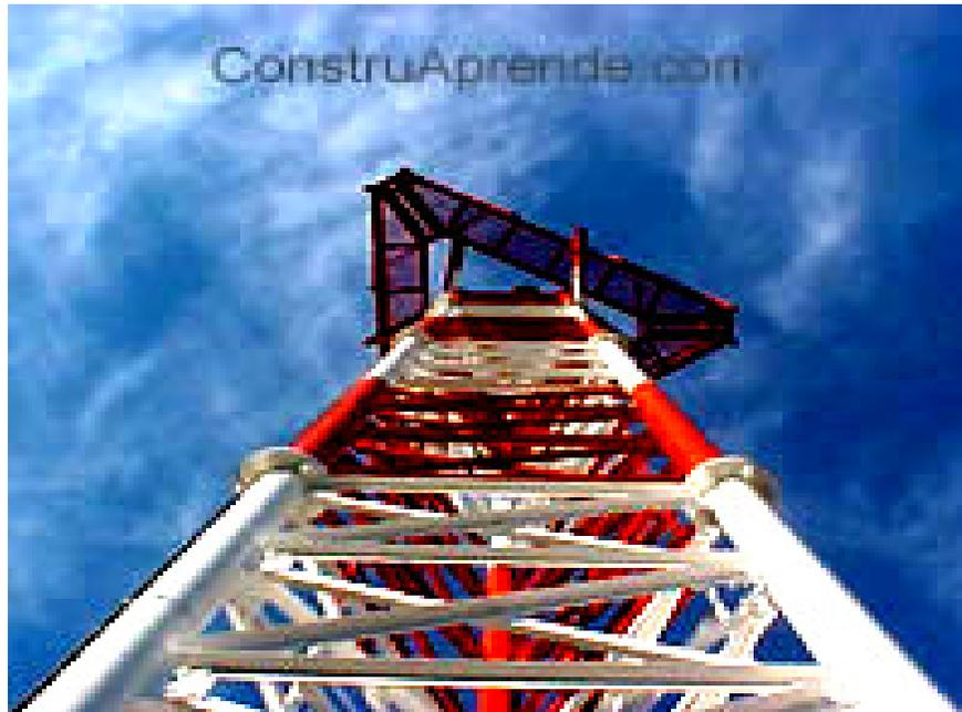
La torre auto soportada dentro del sitio será la encargada de recibir o transmitir las señales para los celulares a grandes distancias. El término auto soportada consiste en que la torre no necesita ningún tensor para poder estar en equilibrio, la cual se sujetará a bases de concreto reforzado que son fundidas en el suelo y su función será el de dar soporte del peso de la torre y anclarla a la superficie.
