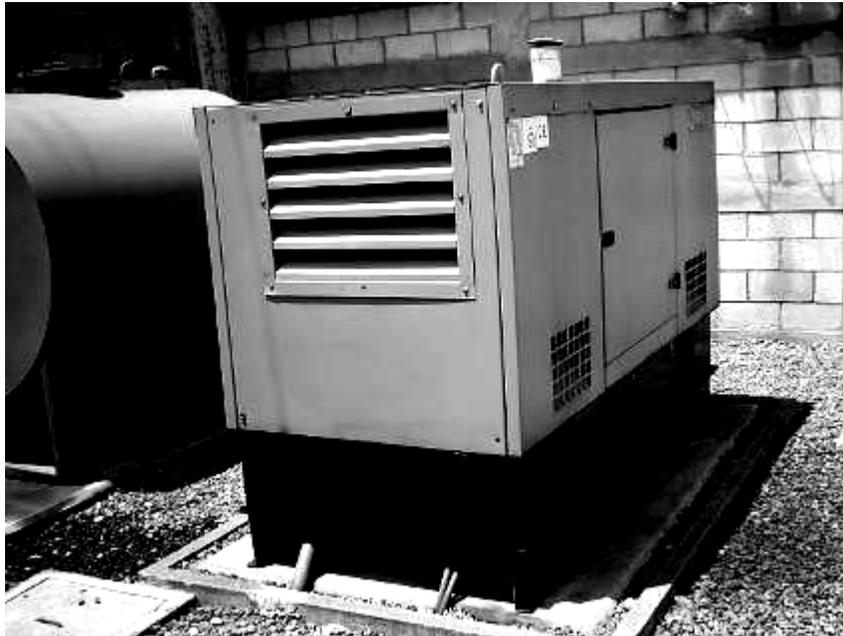
El motor generador es un equipo el cual provee de energía al sitio cuando este tenga irregularidades con la alimentación principal; funciona con combustible diesel y su función principal es la de apoyar y regular el servicio de alimentación de energía de 220 voltios que se necesitan para tener en operación los aparatos internos del sitio.
