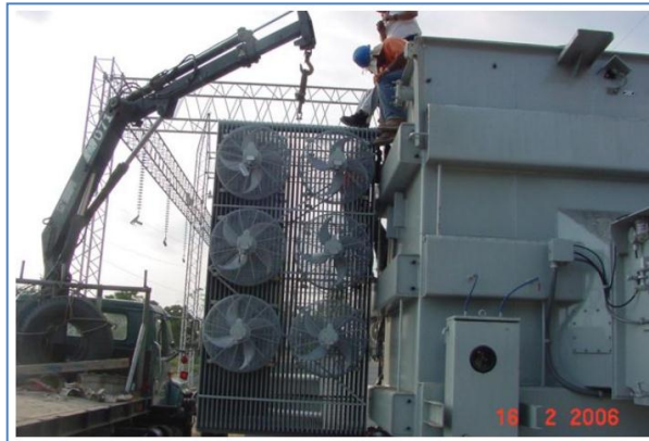
Figura 30. Disposición final de los desechos de un transformador
