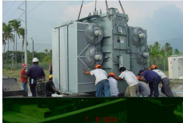
Figura 28. Personal removiendo un transformador
