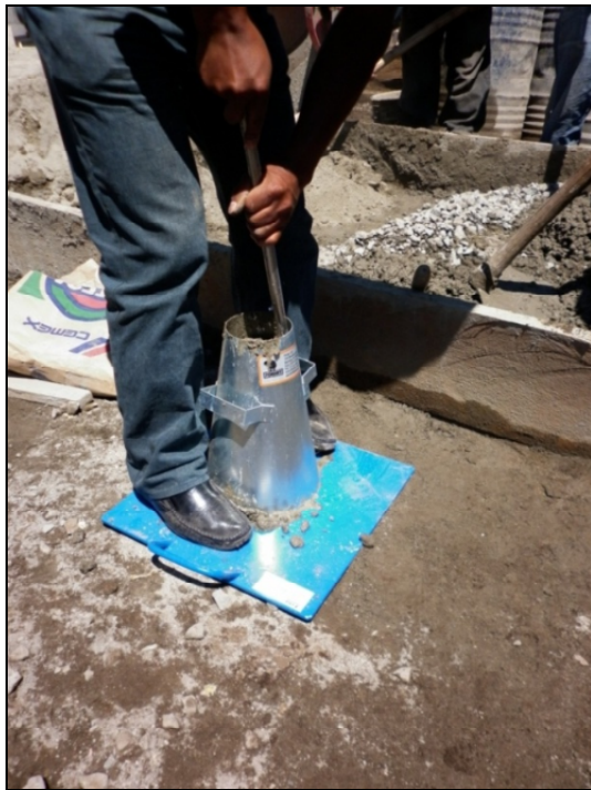
Figura 26. Elaboración de la prueba de asentamiento del concreto
