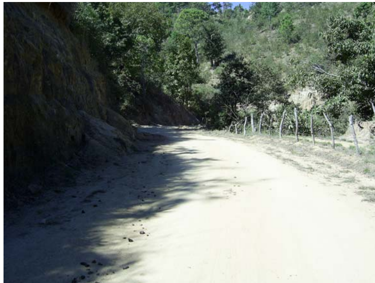
Figura 2 Parte del tramo carretero del proyecto
