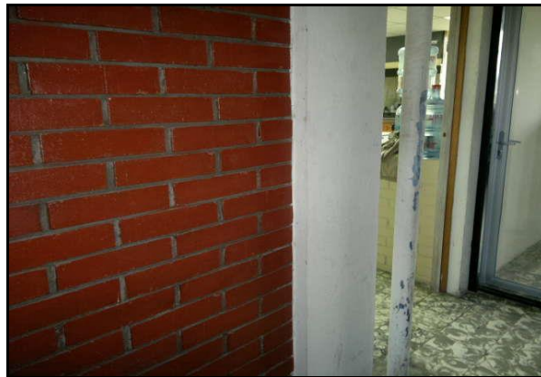
Figura 52. Entrada al Laboratorio de Monitoreo del Aire previo a la señalización
