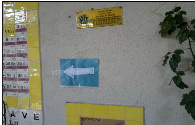
Figura 49. Descanso escaleras 2do a 3er nivel edificio T-10 USAC previo a señalización
