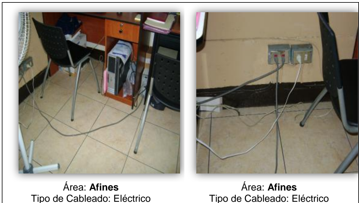
Figura 62. Cableado expuesto
