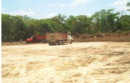
**Material de Base que tendrá un espesor de 15 cm compactado**
