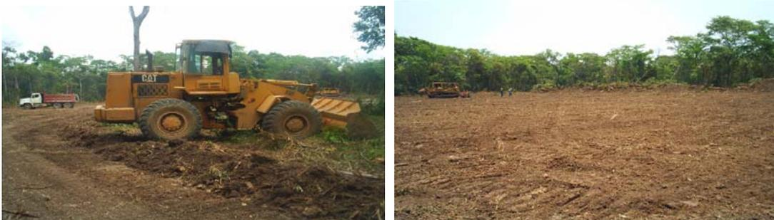
**Nivelación del área de construcción y se aplica la sub-base de 10 cm. de espesor**
