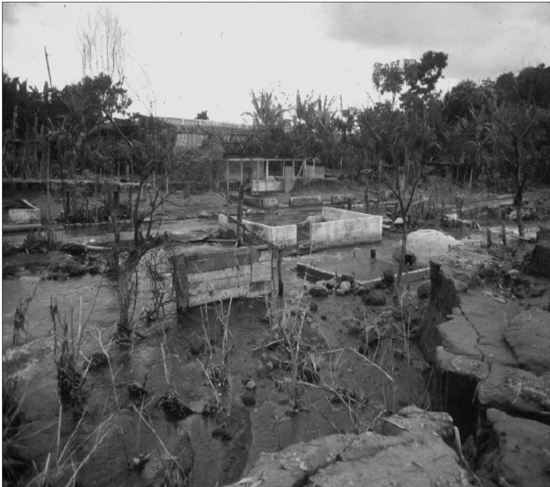
Figura 2. Daños en El Palmar (1983-84)
