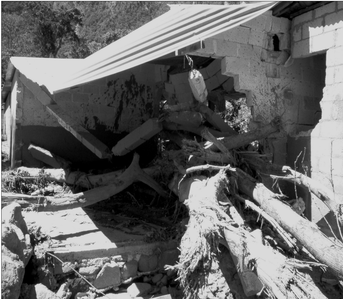
Figura 57. Vivienda destruida por los restos de árboles que conformaban el lahar.
