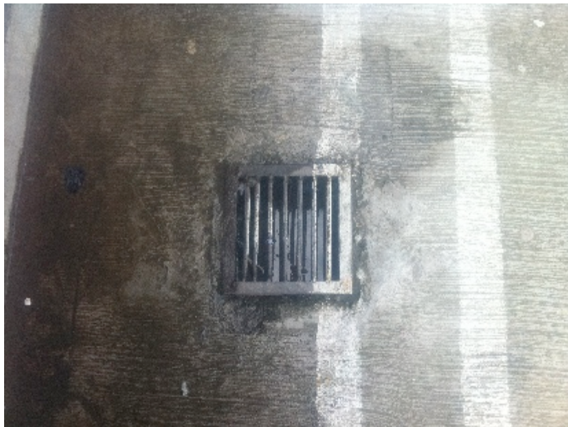
Figura 19. Auditoria de riesgo alcantarilla
