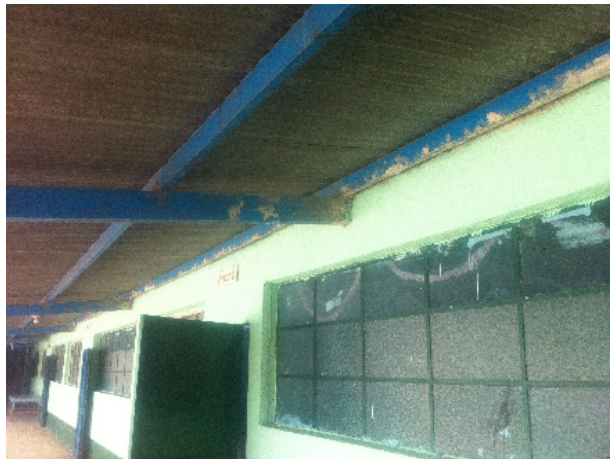
Figura 13. Auditoria de riesgo falta de extintores
