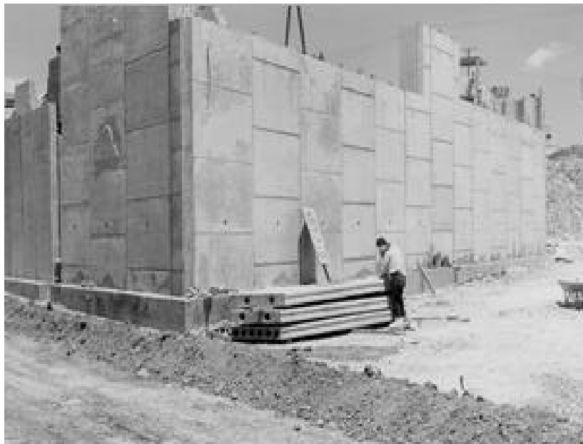
Figura 62. Estribo de contrafuerte prefabricado
