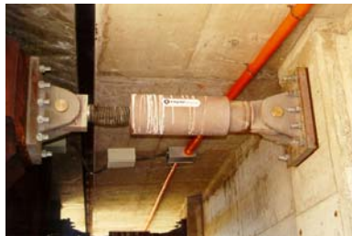
Figura 55. Disipadores viscosos de energía
