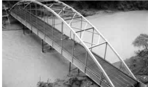
Figura 67. Armadura metálica de puente de paso inferior
