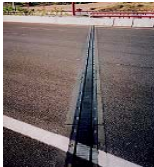
Figura 76. Junta estructural con esviaje
