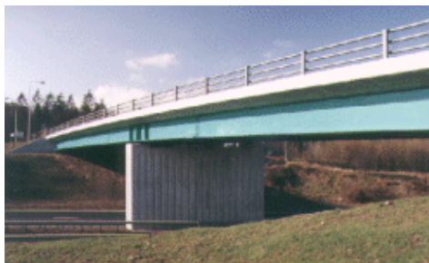
Figura 63. Puente de concreto reforzado de dos tramos
