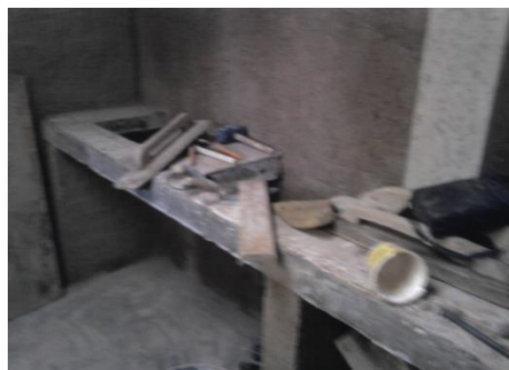
Figura 14. Fotografía de la reconstrucción de los sanitarios (1)
