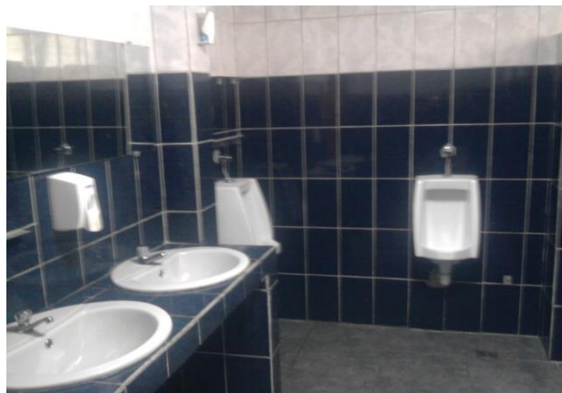
Figura 16. Fotografía de la reconstrucción completa (1)
