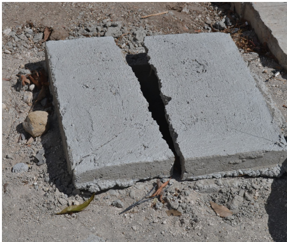
Figura 50. Acceso de agua potable
