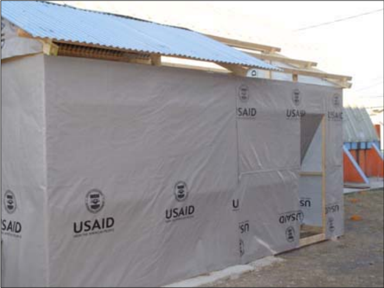
Figura 37. Fotografía de albergue en construcción.
