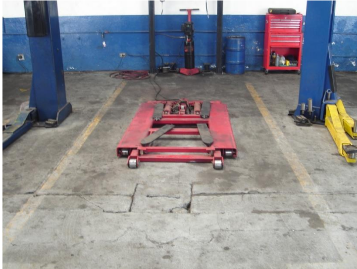
Figura 11. Puente frenero No. 2
