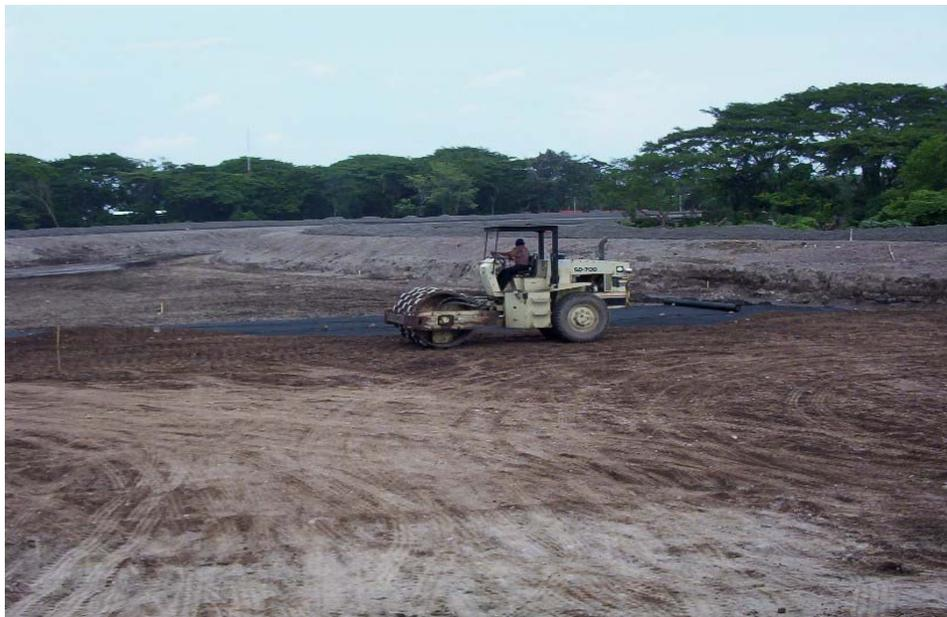
Se puede apreciar el Geotextil instalado y el equipo de compactación trabajando sobre la capa de material seleccionado. (Proyecto Paso a desnivel Puerto Quetzal)
