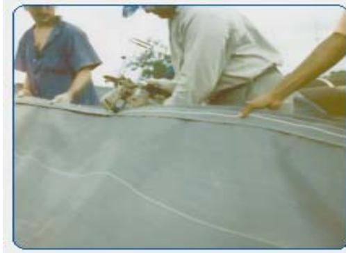
La recomendación a la constructora fue de colocar el geotextil tejido sobre el agua y hundirlo con pequeños rellenos, dado que su peso específico de 0,9 no permitía que se hundiese solo.
