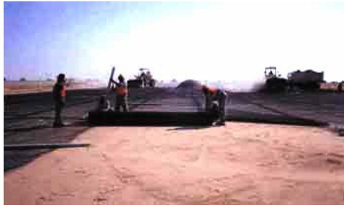
**Figura 18. Las geomallas están diseñadas para trabajar con el trabe de partículas en material friccionante y no sufren daños durante la colocación.**
