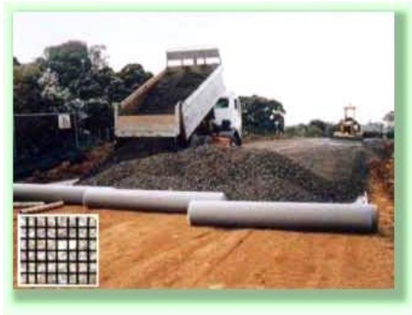
Con la intención de atender las necesidades de la ingeniería geotécnica moderna, se cuenta con una completa gama de geosintéticos para las más diversas aplicaciones. Entre tales geosintéticos se encuentran los geocompuestos para refuerzo de bases, utilizados mundialmente en el refuerzo de base de pavimentos apoyados sobre suelos de baja capacidad de soporte.
