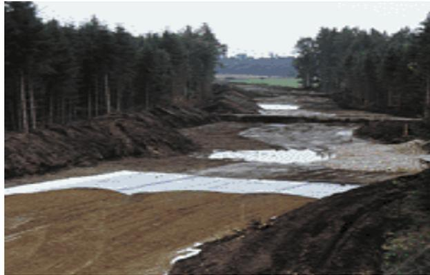
Altshausen (Alemania) Estabilización integral del subsuelo con geotextiles no tejidos y geomallas BIAxIAL
