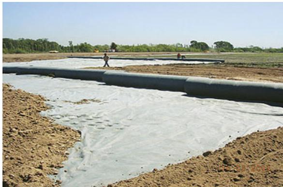
Los ingenieros del proyecto, Freese and Nichols, especificaron el uso de una mezcla en sitio de suelo y lodo para llevar la cubierta a la elevación adecuada e inclinada para permitir el drenaje, pero el primer problema para lograr esto era la inestabilidad de la cubierta. En la primera intervención del contratista, gran cantidad de su maquinaria y equipo quedaron enterrados.
