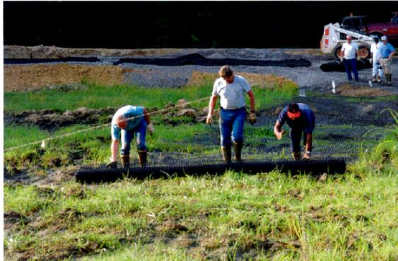
Al utilizar la combinación de Geotextil no tejido + Geomalla se logra evitar que el material que se este colocando penetre hacia las capas del terreno natural y se incruste, por lo que disminuye de una manera considerable el volumen del material que es requerido para el relleno del terraplén hasta una altura de subrasante.
