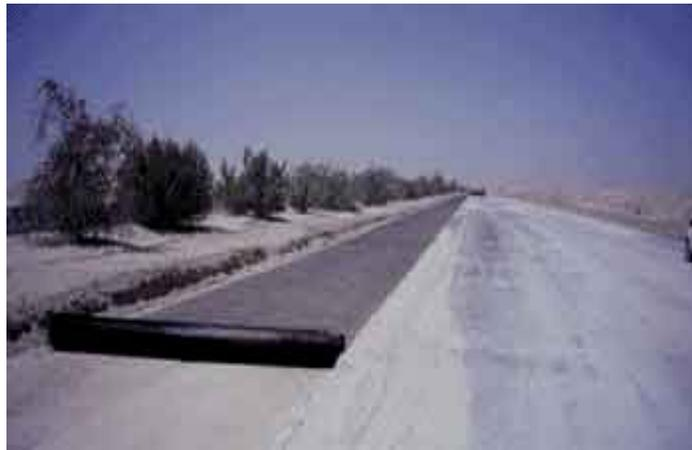
Para estabilizar los terraplenes y evitar los asentamientos diferenciales los ingenieros consultores optaron por una geomalla extruida de polipropileno, ofreciendo alta resistencia de junta y resistencia a daños mecánicos. El mismo producto también fue utilizado para estabilizar y disminuir los espesores de relleno del camino.
