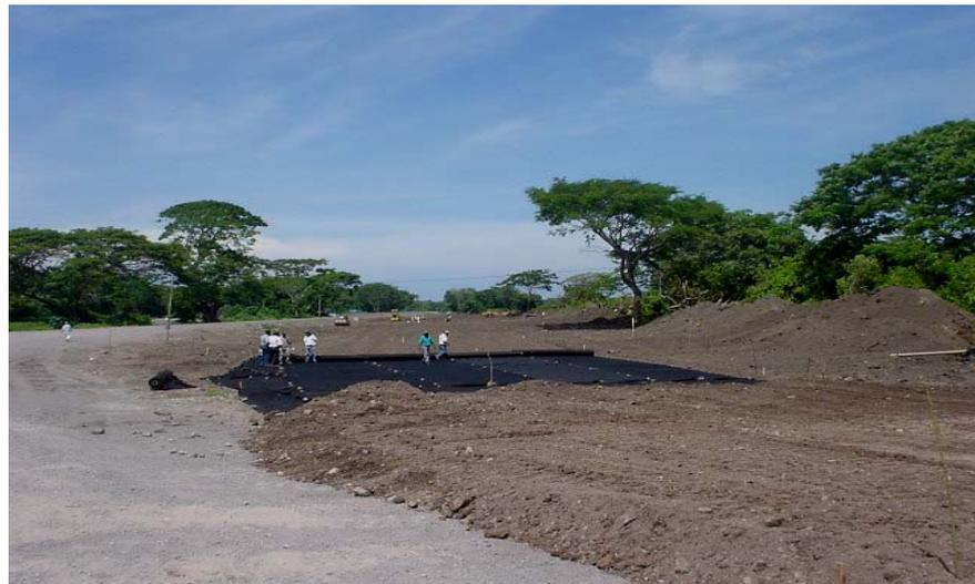
**Figura 57. Aplicación de material de préstamo sobre geotextil**
