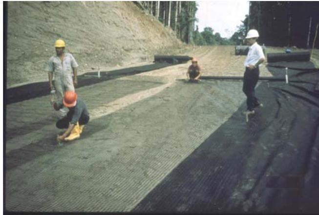
**Figura 3. Geomallas mono orientadas**
