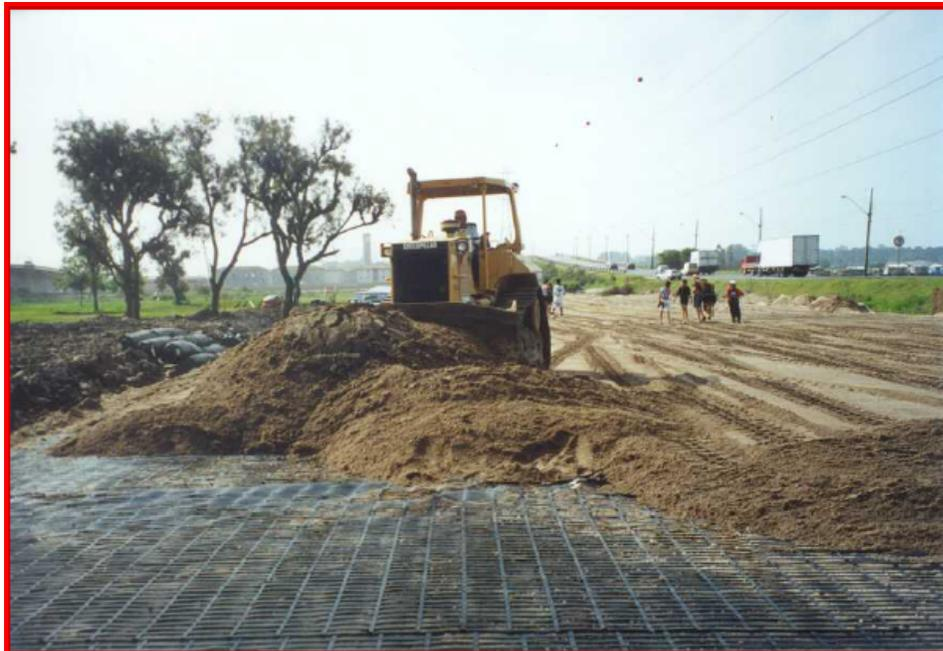
**Figura 54. Colocación de base granular**
