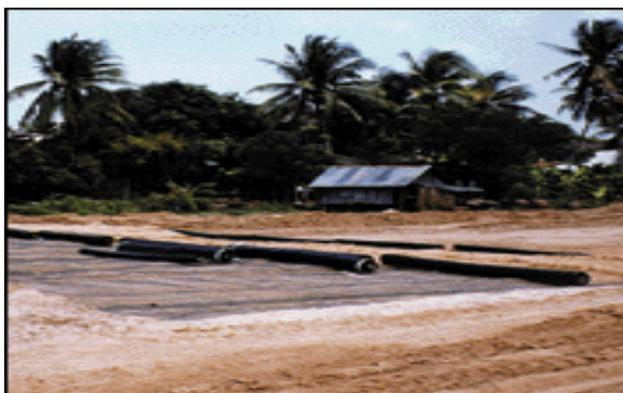
Bangkok (Tailandia) Estabilización en la base de una autopista construida normalmente sobre arcilla consolidada y compresible, con geomallas BIAxIAL
