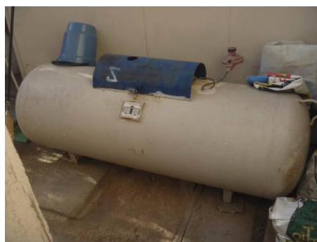
Figura 6. Tanque de gas propano
