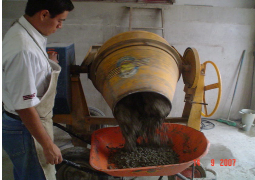
Figura 6 Elaboración de concreto
