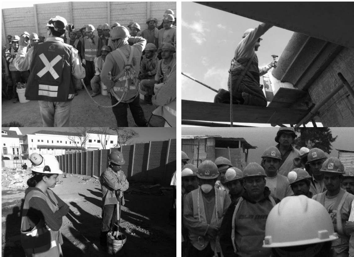
Figura 11. Seguridad industrial en obra
