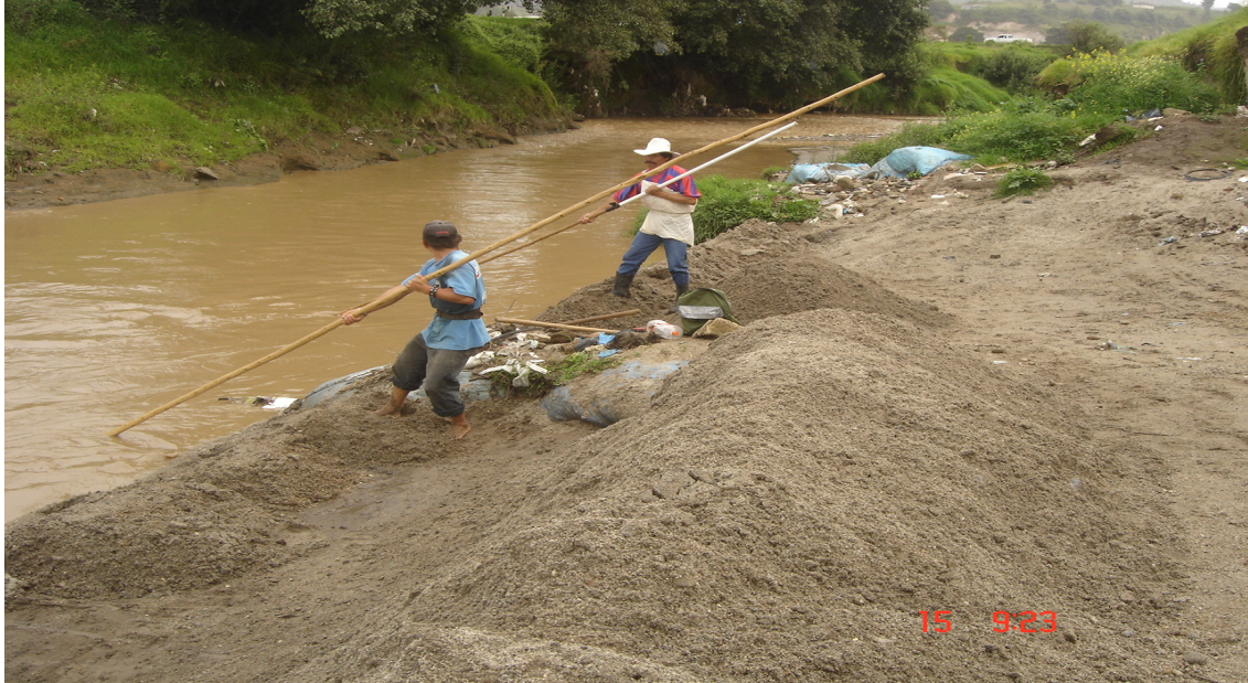
Figura 10. Fotografía de carga del agregado fino.
