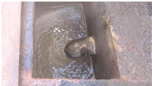
Figura 12. Sistema recolector de aguas de limpieza de maquinaria de una planta de jabones
