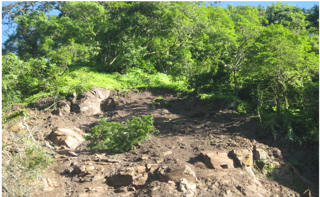
Figura 5. Tala de árboles y limpieza del área para dar inicio a la explotación de un banco de material.
