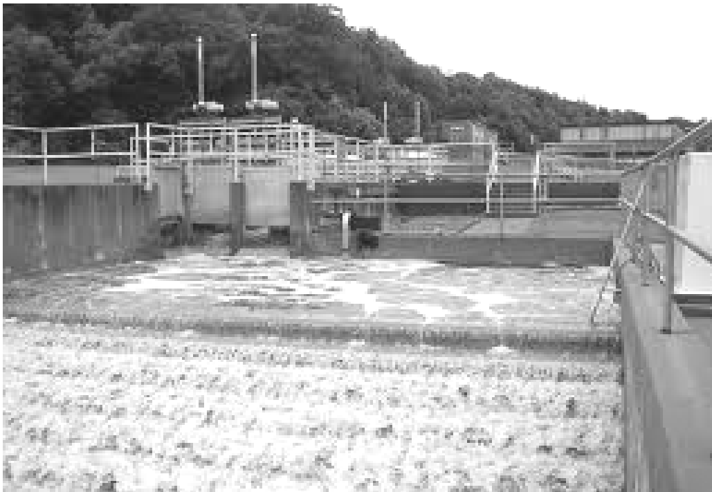
Figura 14. Planta de tratamiento de agua por floculación
