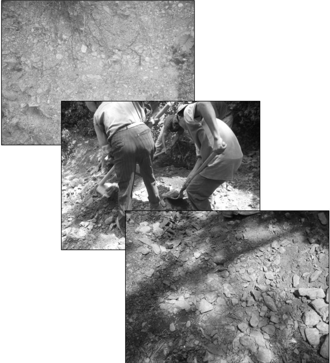
Se asumirá un valor soporte de  $32 \text{ Ton/m}^2$ , correspondiente a un suelo arenoso.
