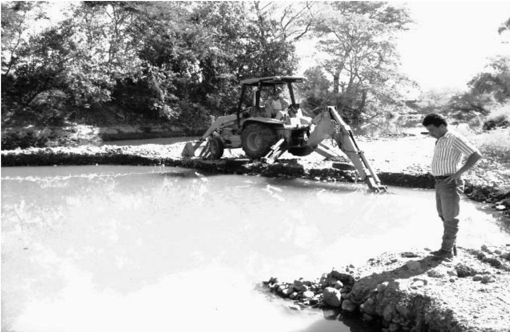
Figura 3. La fotografía muestra el momento en el cual se extrae el material para la construcción del banco de materiales del río Ostúa.
