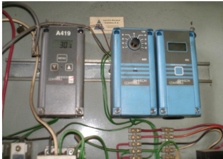
Figura 38. Dispositivos de control de temperatura y humedad relativa
