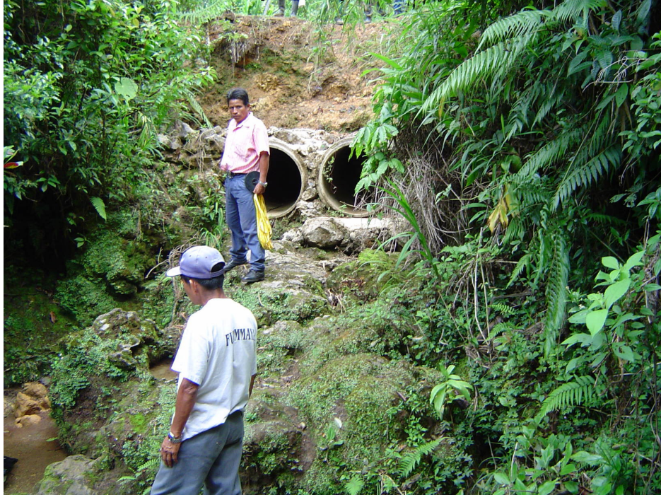
Figura 39. La corriente se filtra debajo de la tubería por lo que para invierno se rebalsa el camino según información de los comunitarios.
