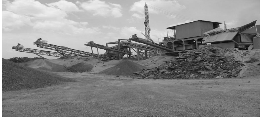
Figura 6 Escoria de acería, proceso de limpieza. Planta SIDEGUA, Escuintla Guatemala
