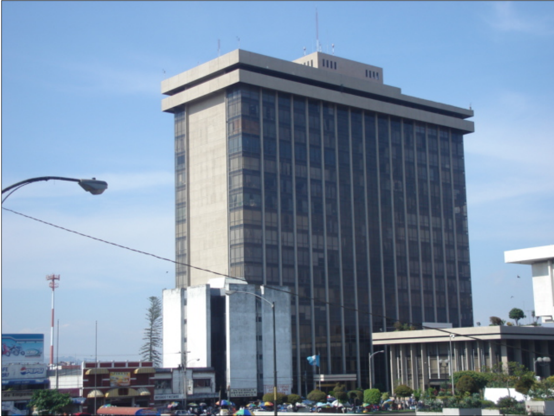
Figura 14. Estructura de acero.
