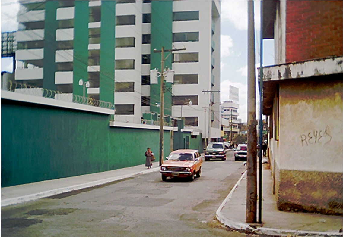
Figura 13. Fotografía de estructura de concreto
