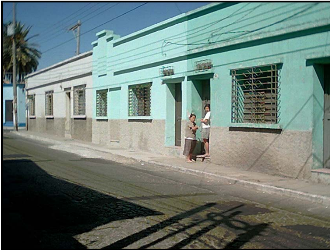
Figura 11. Fotografía de estructuras de adobe
