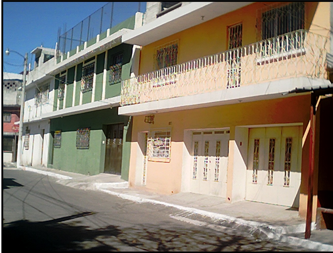
Figura 12. Fotografía de estructura de mampostería media
