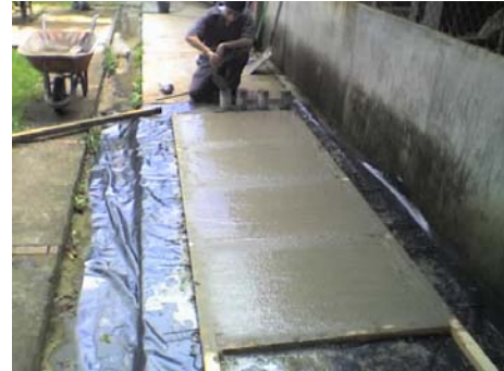
Figura 41. Plaquetas recién fundidas.
