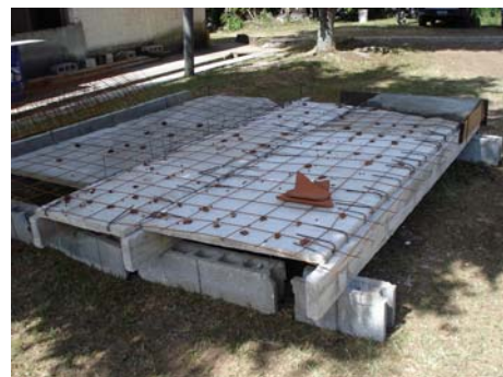
b) Elementos de Vigueta + plaqueta montados y listos
