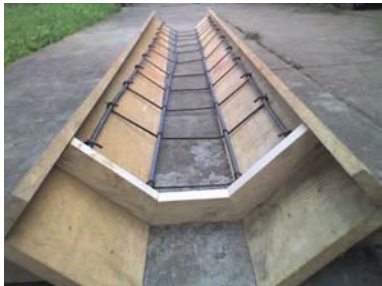
Figura 30. Armadura y formaleta BATEA
