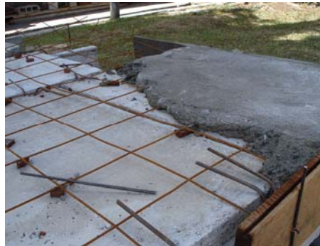
Figura 44. Cubierta preparada para Fundición de capa superior de concreto
