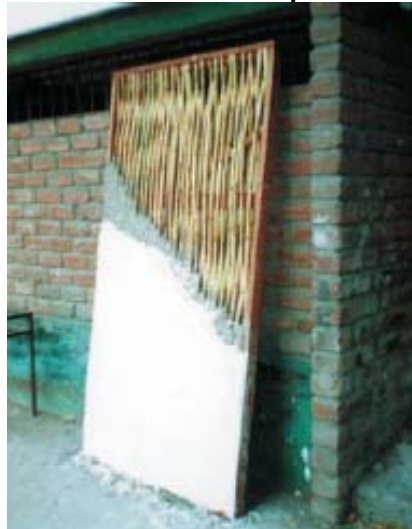
Figura 7. Muestra de un elemento en proceso de construcción
