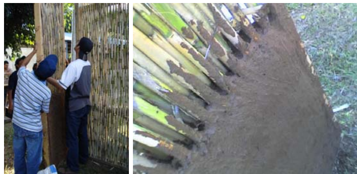
Figura 11. Instalación del marco y aplicación de Primer recubrimiento de barro.
