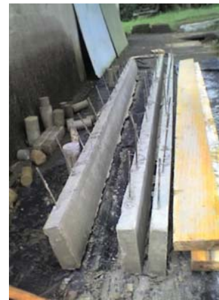
Figura 42. Desencofrado de los elementos
