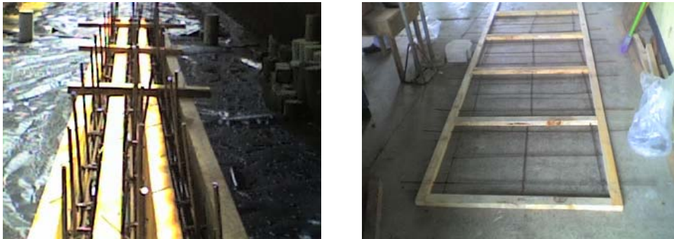
Figura 39. Imagen de formaletas su respectiva armadura.
