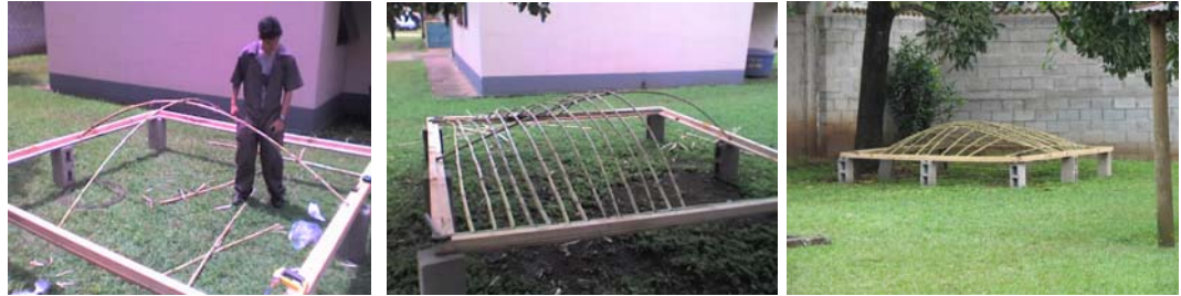
Figura 14. Armado de la estructura de cañas.
