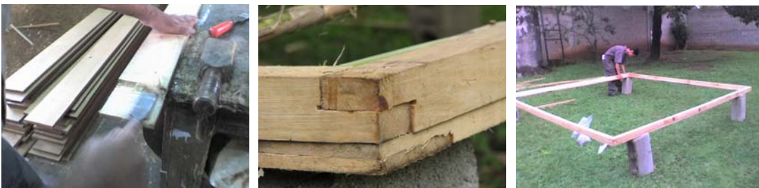
Figura 13. Preparación del marco de madera
