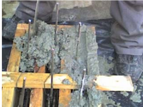
Figura 40. Llenado de las viguetas
