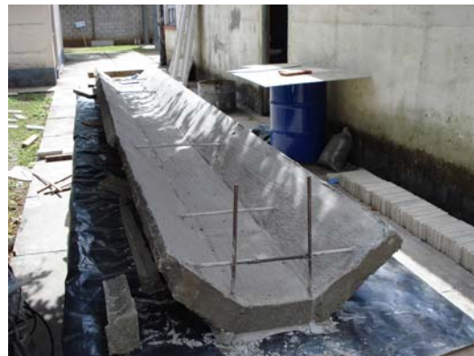
j) desencofrado de BATEA "T"
