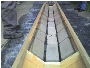
Figura 32. Colocación de los ladrillos y armadura en la formaleta
