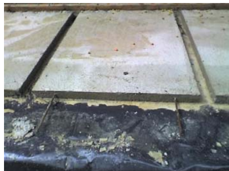
Figura 42. Desencofrado de los elementos
