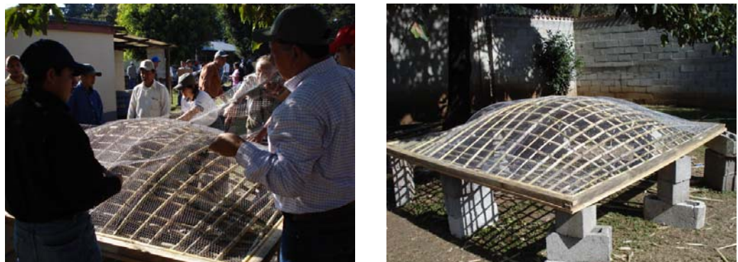
Figura 15. Instalación de la malla de gallinero a la estructura de cañas de bahareque.
