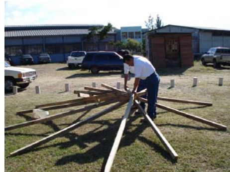
b) Practica del taller de Techos de Barras de madera
