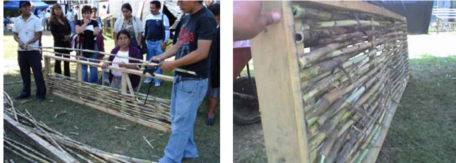
Figura 9. Marco y trenzado de las cañas
