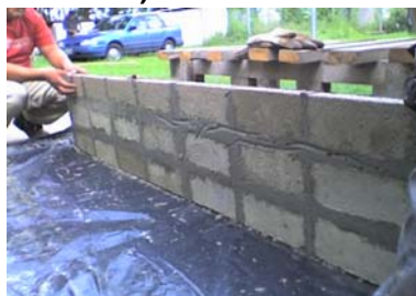
Figura 26. Vista exterior de la placa BENO (suelo-Cemento)
