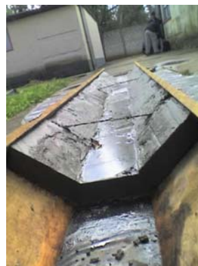
Figura 35. Desencofrado de la pieza
