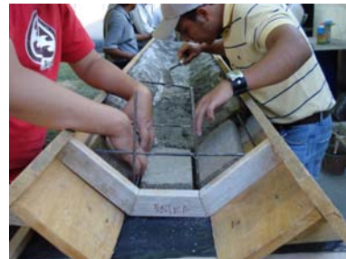
Figura 33. Fundición del módulo
