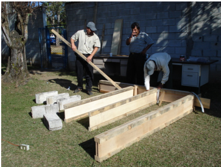
Figura 51. Construcción de un techo VIMA
