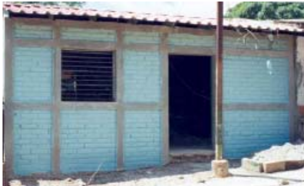
Figura 1. Construcción hecha con ladrillos de suelo cemento
