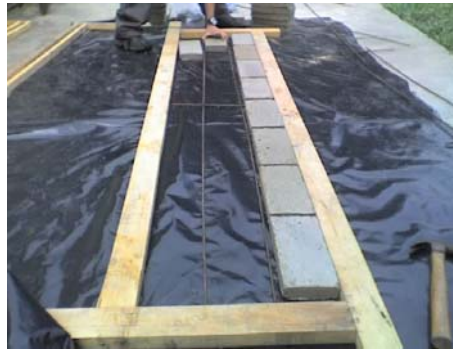
Figura 23. Colocado de los ladrillos en el molde de madera.
