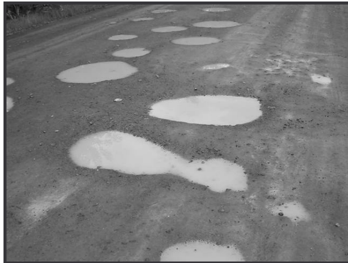
Figura 11. Situación de la carretera antes de la intervención
