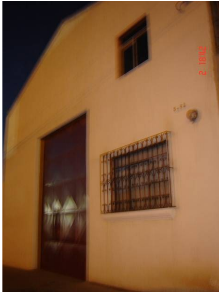
Figura 4. Fachada de la bodega valuada
