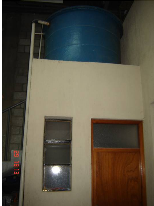
Figura 12. Baño para área de oficinas en bodega
