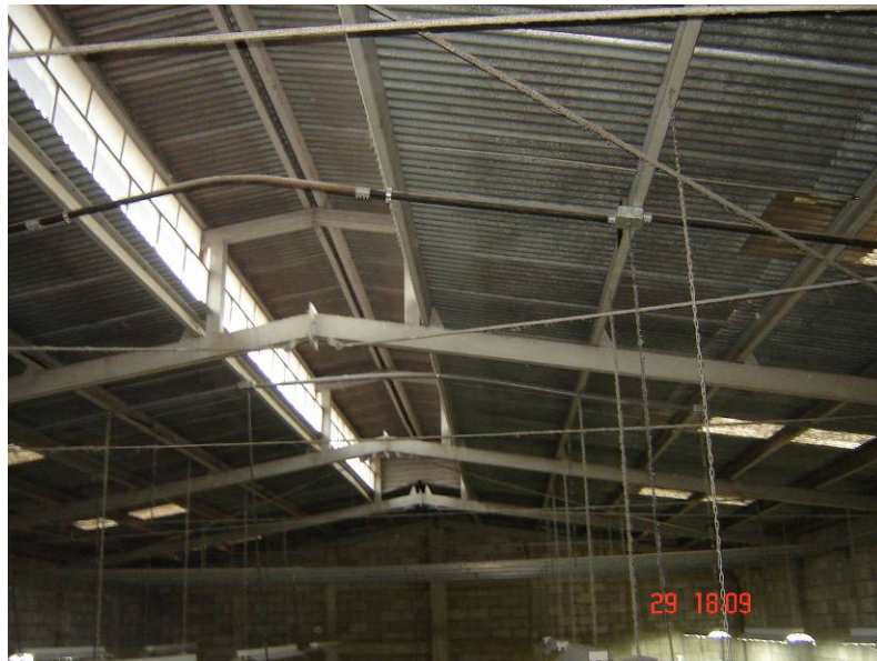
Figura 9. Estructura metálica e instalaciones eléctricas de bodega valuada
