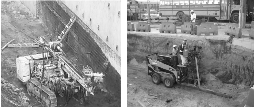
Figura 19. Equipo utilizado en el medio para realizar perforaciones y colocar anclajes.
