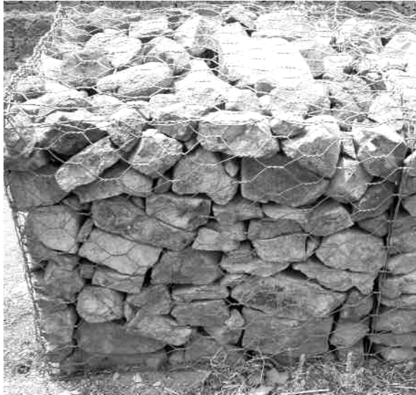
Figura 7. Detalle típico de los gaviones comerciales en Guatemala.
