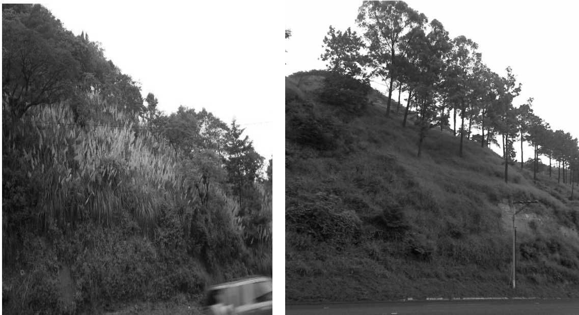
Figura 37. Taludes recubiertos de vegetación en condiciones naturales.
