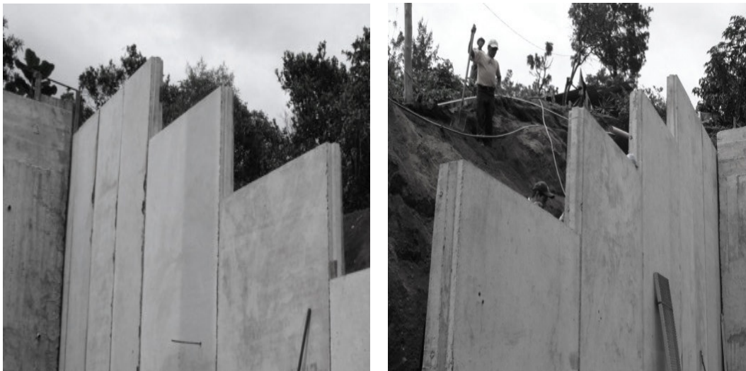
Figura 22. Muro tipo tablestacas
