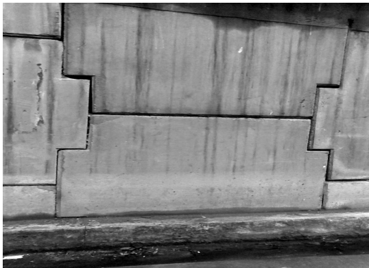
Figura 14. Muros de Tierra Reforzada, geotextil, tiras y mallas metálicas.
