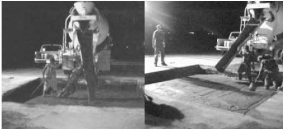
Bacheo en aeropuerto de Acapulco, México
