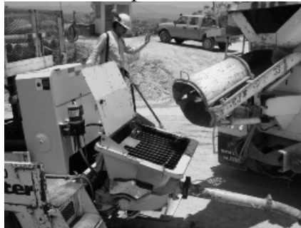
Figura 7 Descarga de Relleno Fluido en Bomba para concreto
