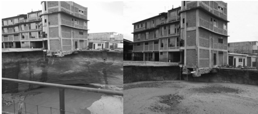
Avance del nivel del relleno en el Barrio San Antonio
