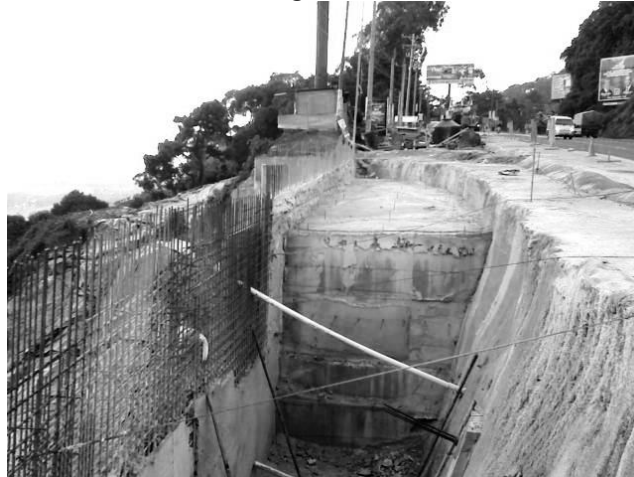
Relleno en derrumbe del km. 9.5 a El Salvador
