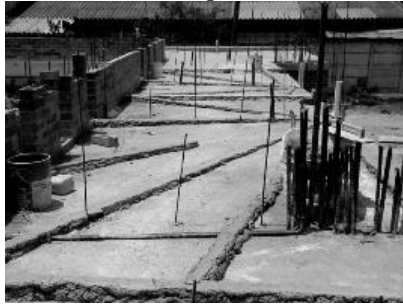
Figura 22 Losa con aislamiento y bajadas de agua
