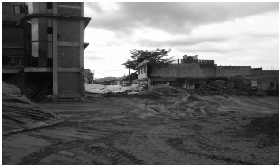
Vista final del relleno en el Barrio San Antonio
