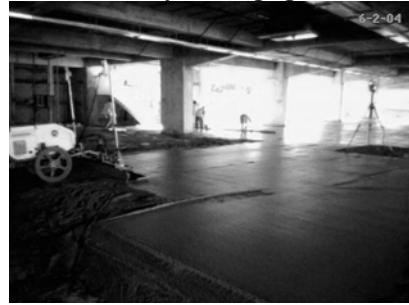
Figura 23 Losa nivelada con relleno fluido con ayuda equipo láser
