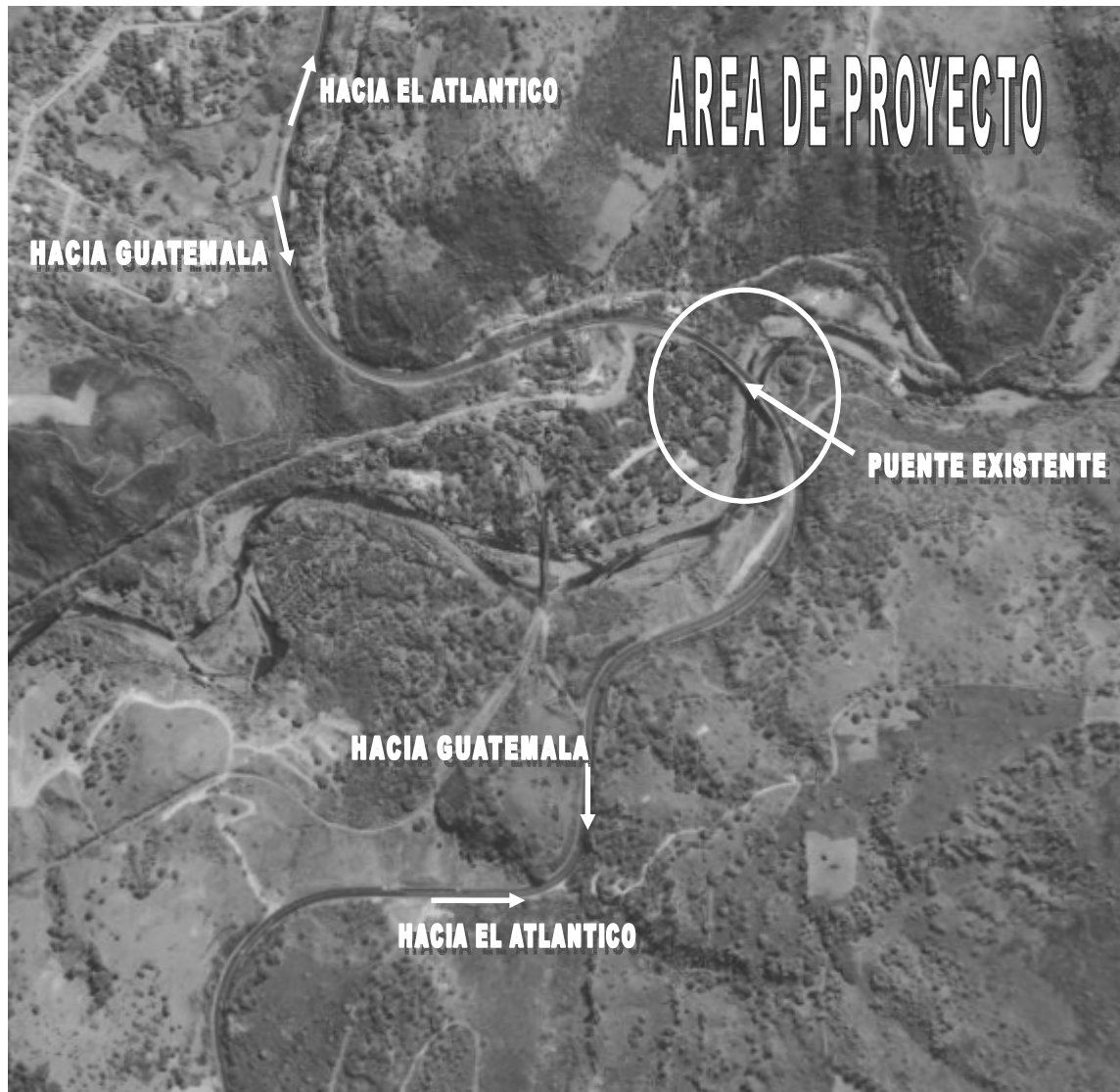
Figura 2. Fotografía aérea del puente existente
