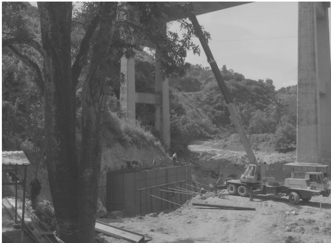
Encofrado del cajón y detalles previos para la fundición de la base.
