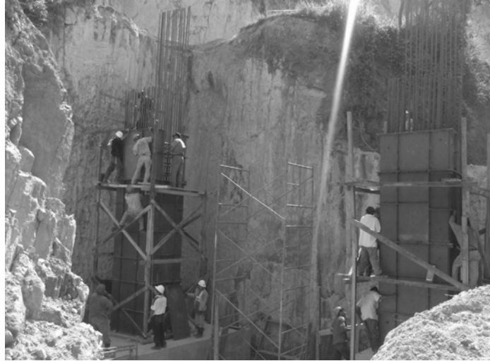
Figura 31a. Encofrado de columnas
