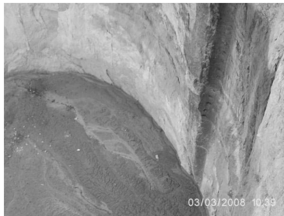
Hundimiento de Barrio San Antonio zona 6, de 10 metros de profundidad.
