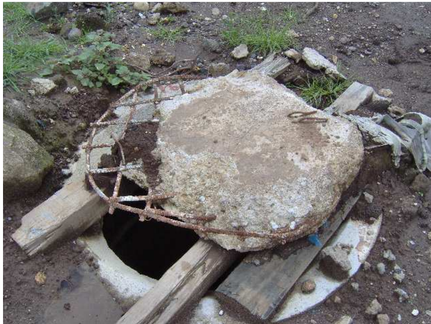
Figura 35: Tapadera de pozo de visita en mal estado
