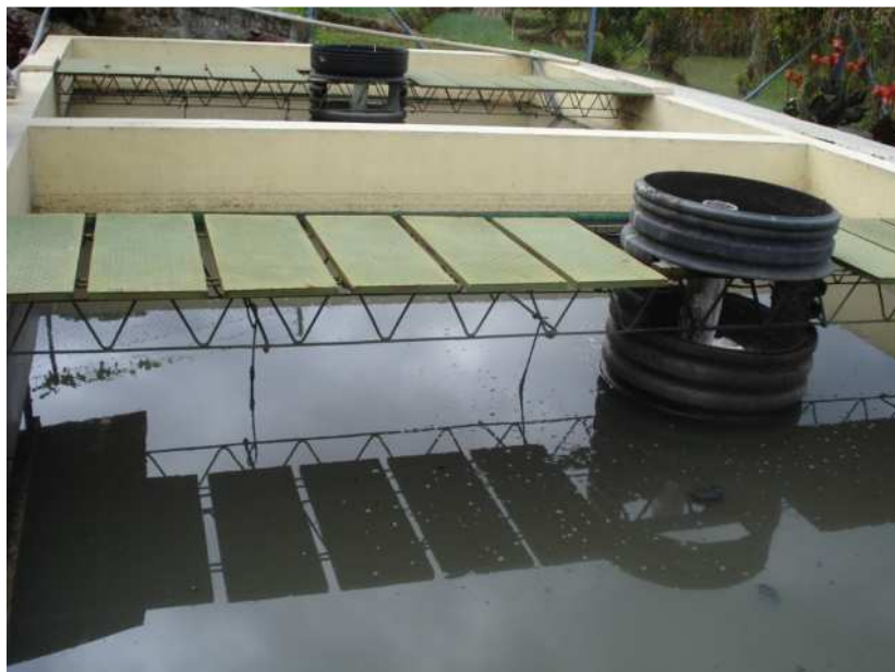
Figura 19: Decantadores secundarios de la planta de tratamiento San Antonio
