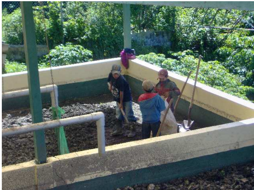
Figura 14: Patio de secado de lodos de la planta de tratamiento San Bartolo
