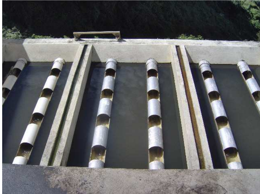
Figura 14: Patio de secado de lodos de la planta de tratamiento San Bartolo
