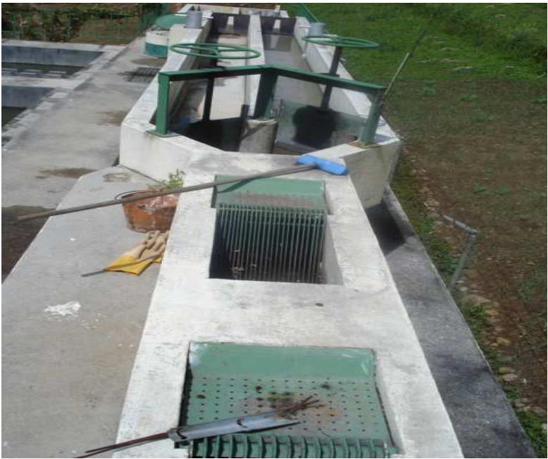
Figura 10: Tratamiento preliminar de la planta de tratamiento San Bartolo
