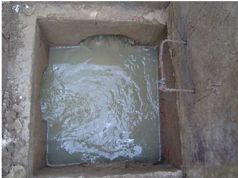
Figura 33: Caja de visita colmatada de arena y basura
