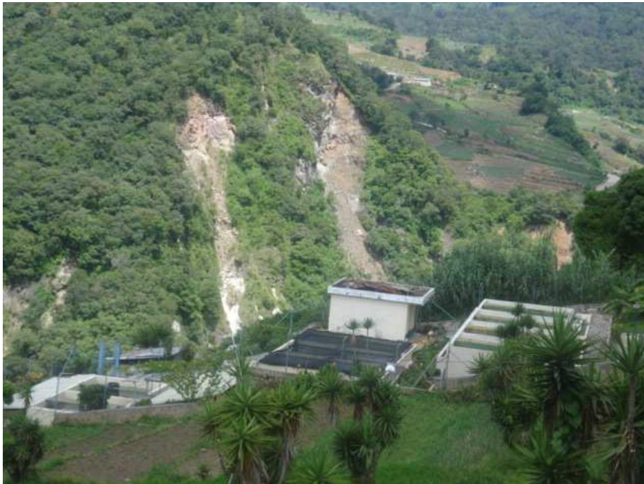
Figura 15: Planta de tratamiento San Antonio
