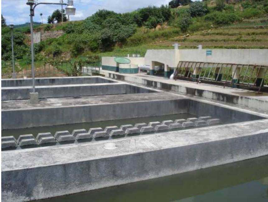
Figura 12: Filtros percoladores de la planta de tratamiento San Bartolo
