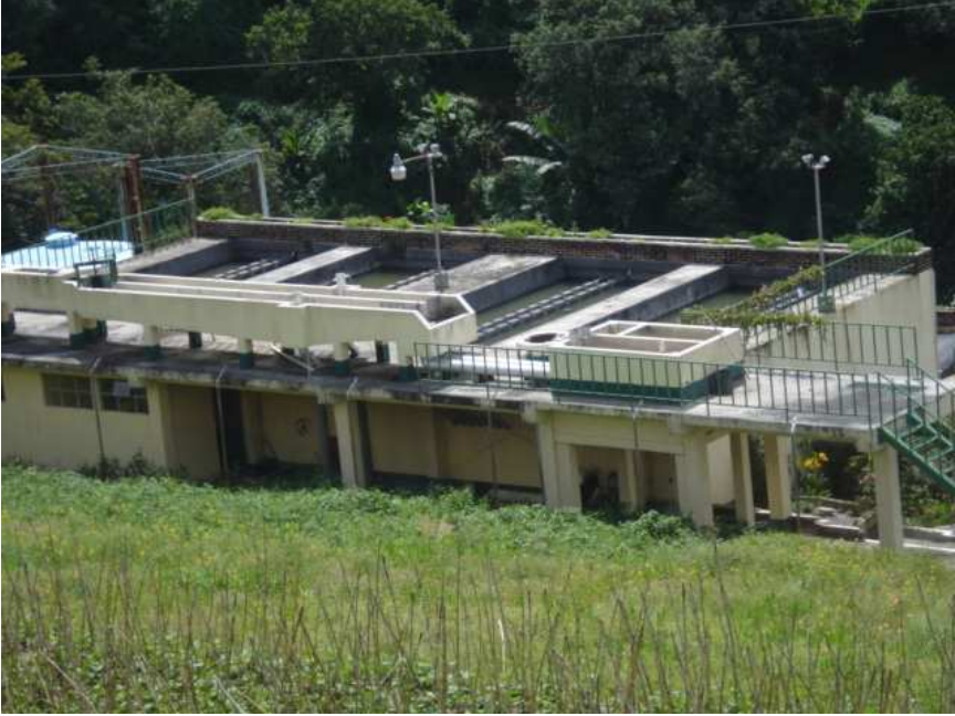
Figura 10: Tratamiento preliminar de la planta de tratamiento San Bartolo
