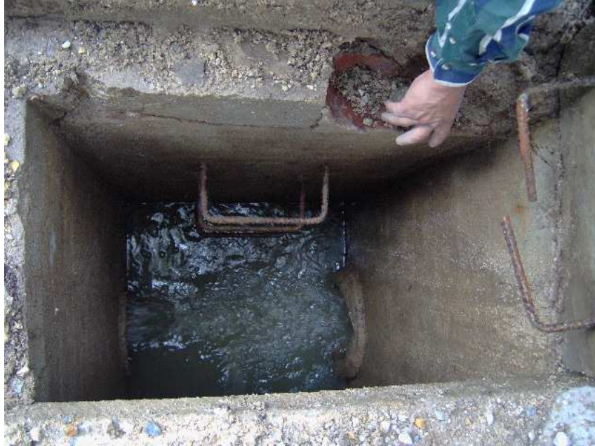
Figura 33: Caja de visita colmatada de arena y basura
