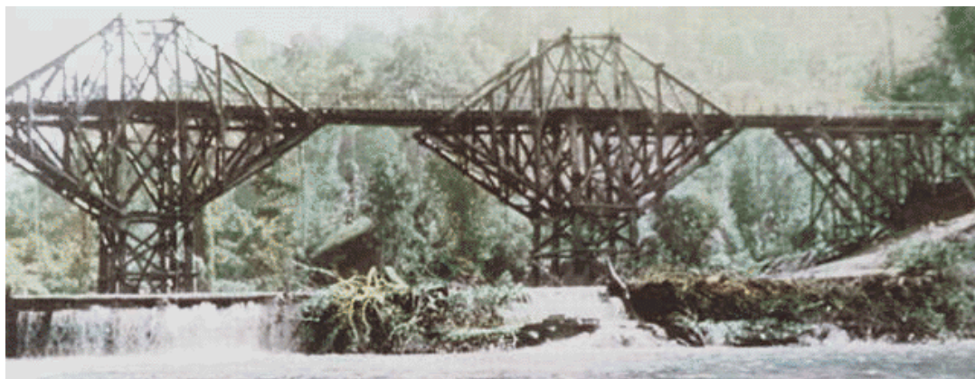
Figura 6. Puente de madera.
