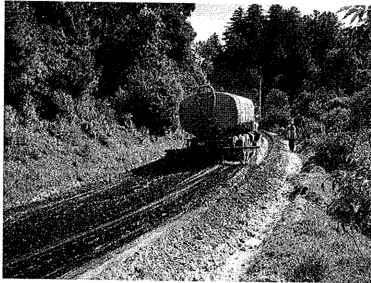
Figura 23. Riego de emulsión asfáltica
