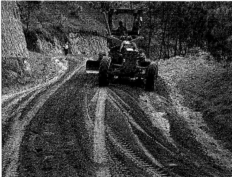
Figura 20. Escarificación del tramo
