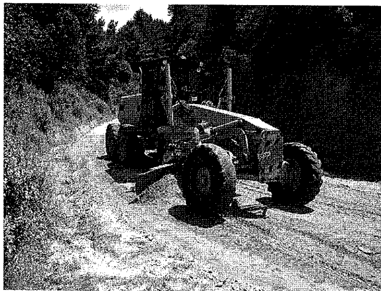
Figura 22. Mezcla y homogeneización del material.
