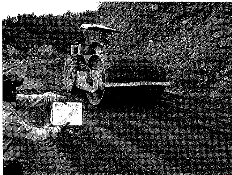
Figura 26. Compactación del material estabilizado
