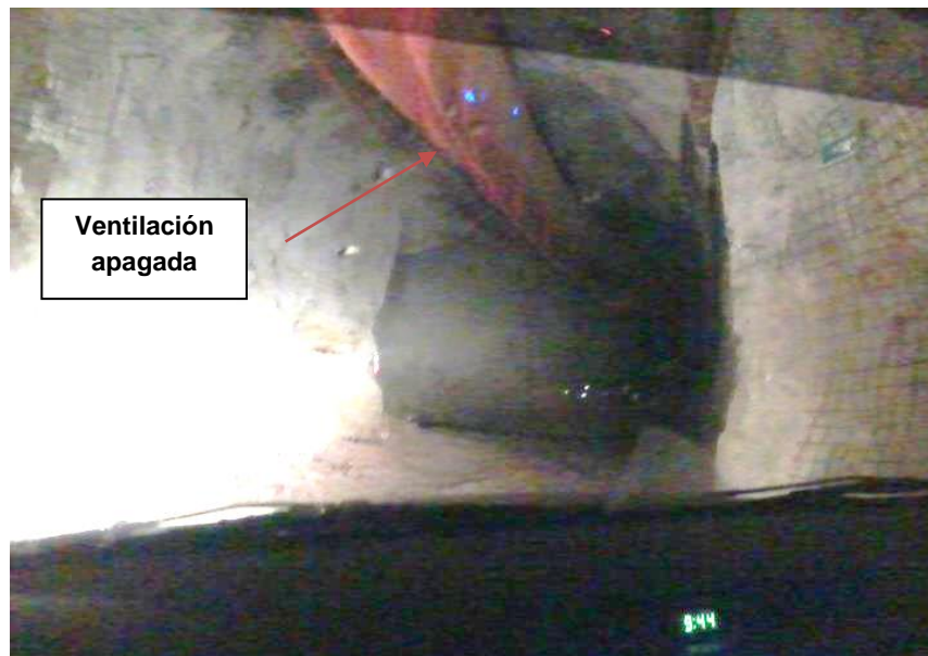
Figura 16. Manga de ventilación apagada en mina subterránea
