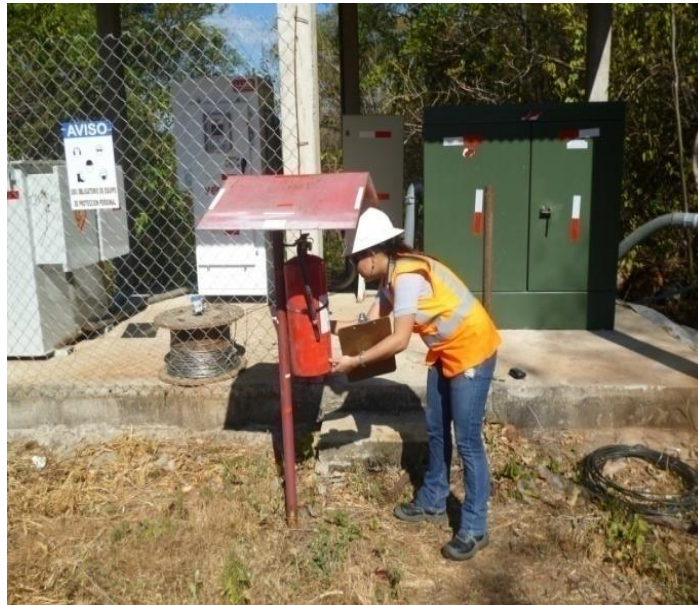
Figura 27. Inspección de extintores en áreas de proyecto Cerro Blanco
