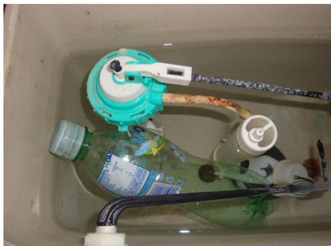
Figura 37. Colocación de recipiente para ahorro de agua en sanitario de área administrativa del proyecto Cerro Blanco
