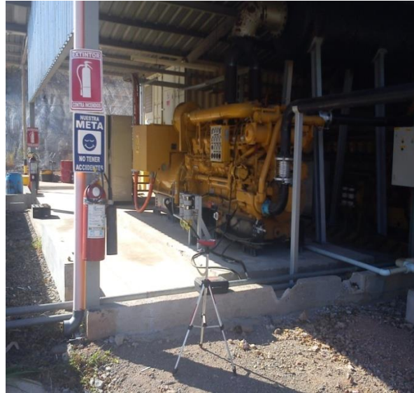
Figura 36. Medición de ruido en área de generación
