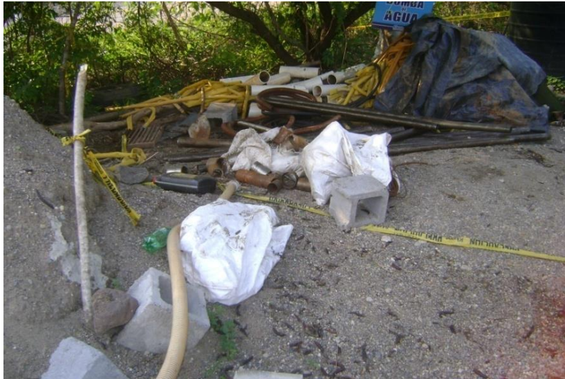
Figura 6. Área de construcción de chimenea
