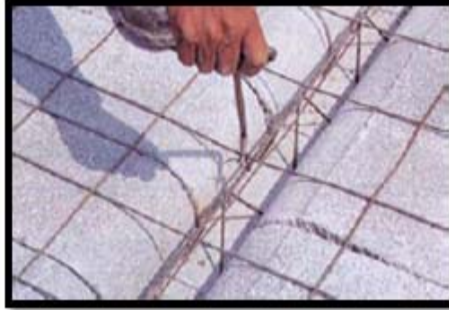
Figura 35. Colocación de electromalla
