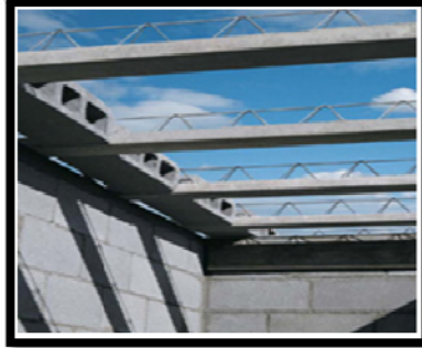
Figura 33. Nivelación de viguetas
