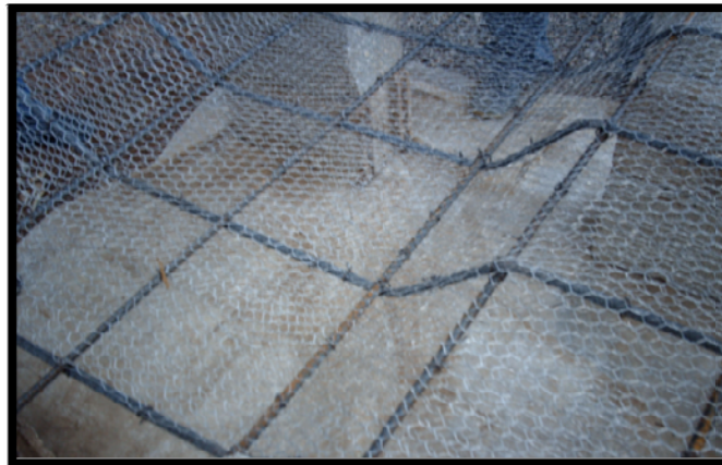
Figura 41. Armado de losa de ferrocemento
