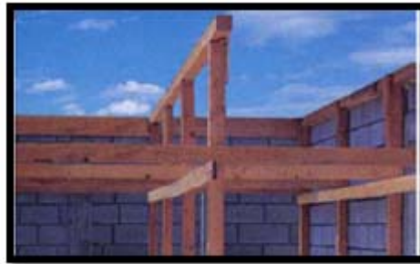
Figura 37. Colocación de parales y costaneras
