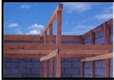
Figura 31. Colocación de parales y costaneras
