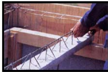
Figura 32. Colocación de viguetas
