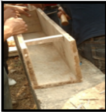
Figura 5. Encofrado de madera
