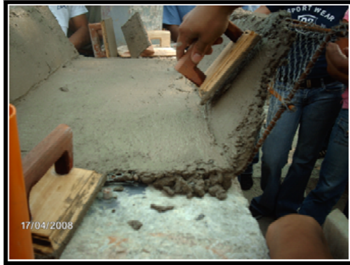
Figura 5. Colocación de mortero para losa de ferrocemento
