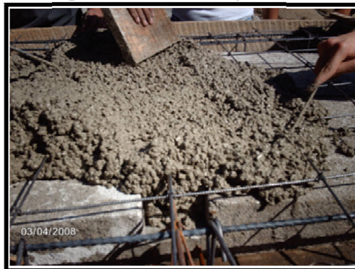
Figura 6. Fundición de losa prefabricada
