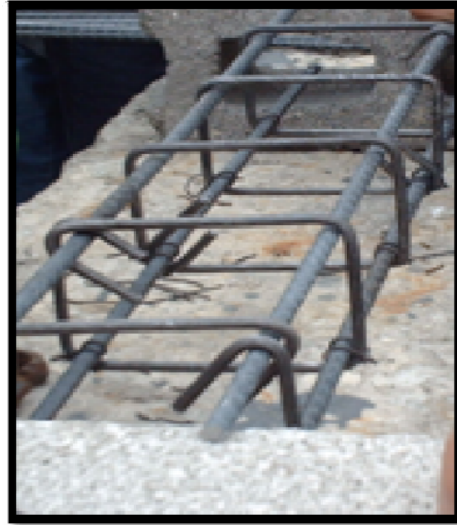
Figura 19. Detalle de armado de columna rectangular
