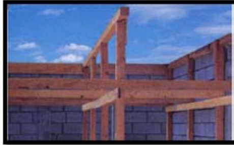
Figura 39. Colocación de parales y costaneras
