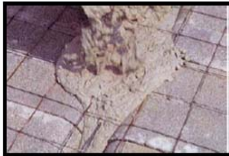
Figura 36. Fundición de losa
