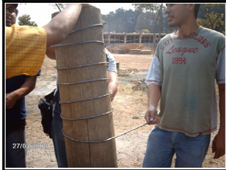
Figura 4. Elaboración de estribos para columna rectangular
