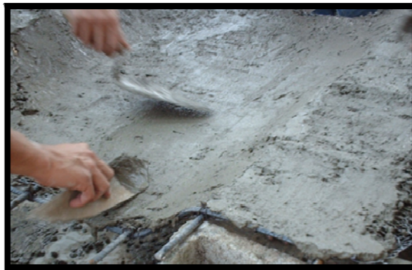
Figura 42. Colocación de mezcla al armado de losa de ferrocemento
