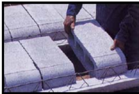
Figura 34. Colocación de bovedilla
