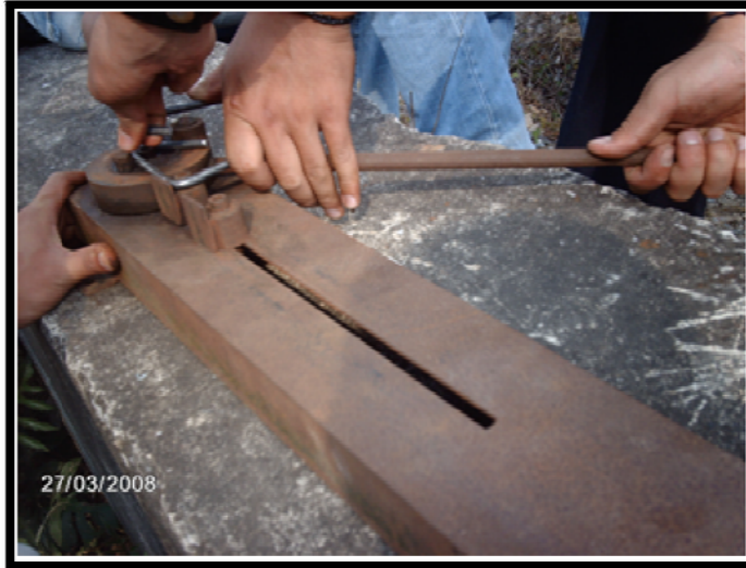
Figura 3. Elaboración de estribos para columna rectangular
