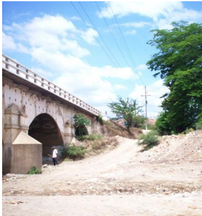
Figura 20. Fotografía del ingreso al banco de materiales 1.
