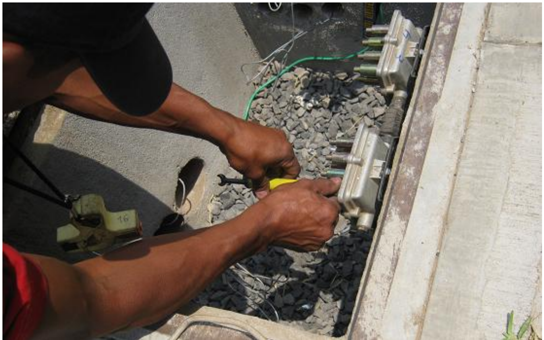
Figura 16. Forma correcta de usar el torquímetro en TAP
