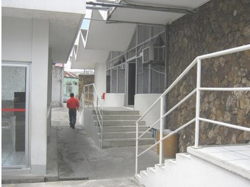
Figura 41. Fotografía escaleras de edificio Guarda Viejo I
