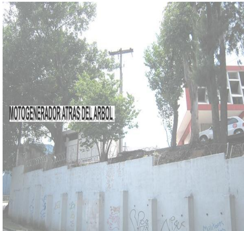
Figura 44. Fotografía zona de riesgo 2
