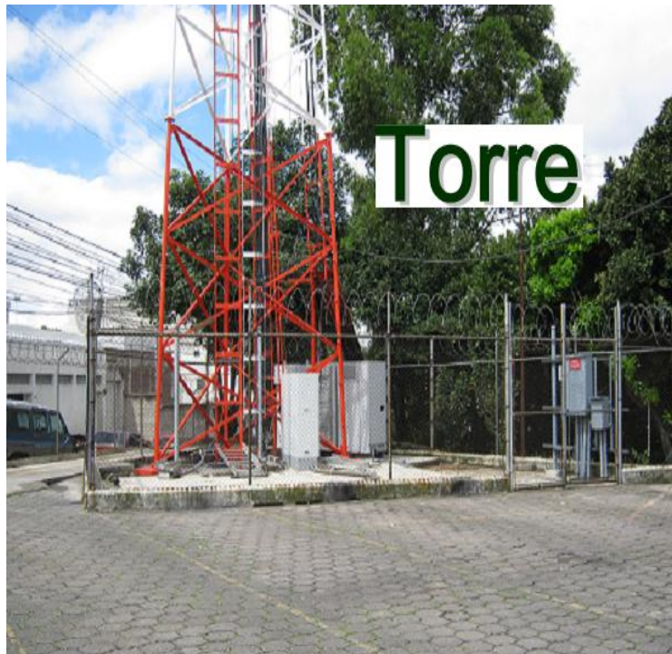
Figura 45. Fotografía zona de riesgo 3
